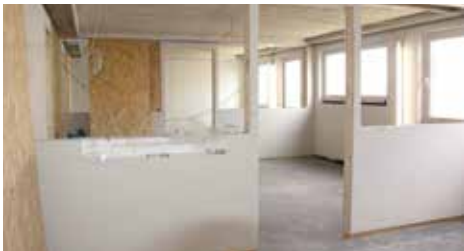
Umbau „altes“ Lager zu Büroräumen
